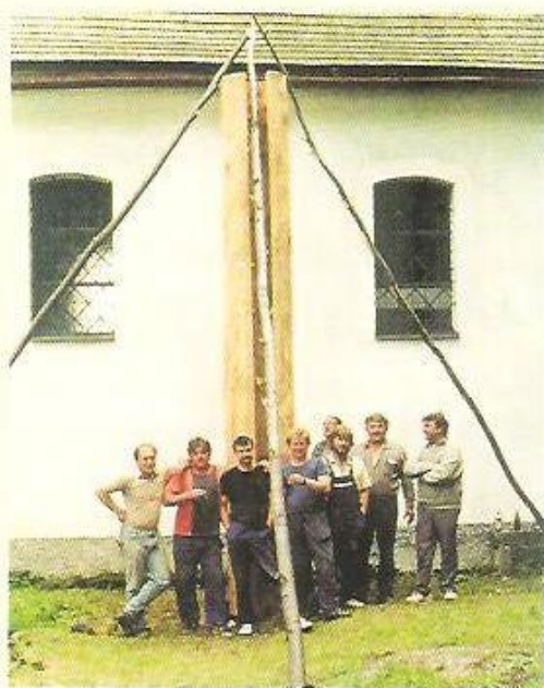
▲ Stavba relikviáře světla u románského kostela v obci Hliza pod Sítmem, 1994
